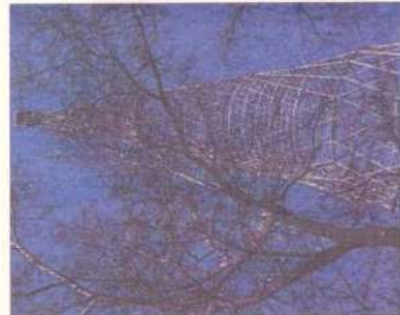
6. Радиобашня (впоследствии телебашня) Шухова на Шаболовке
